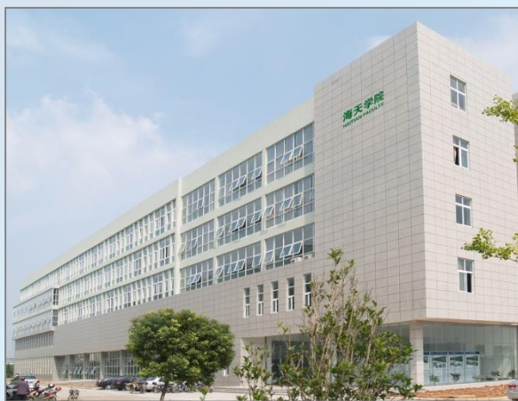
海天集团投入1000万元资金在校内建设的实训大楼
